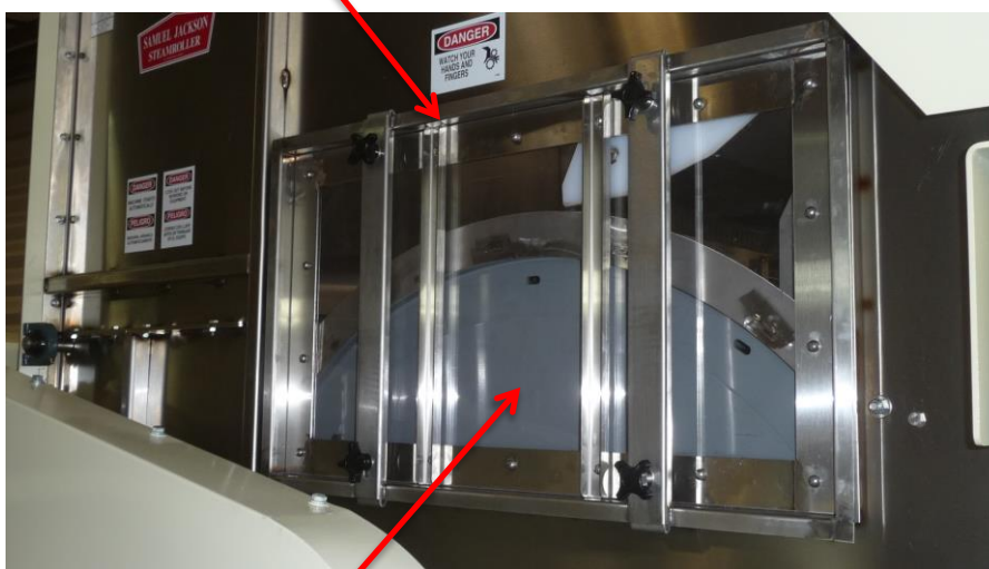
Ensemble porte d'accès avec fenêtre
