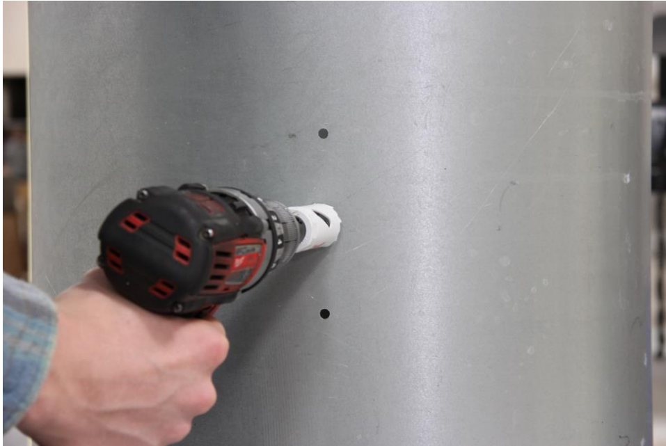
Figure 3: Découper le trou central avec la scie-cloche
