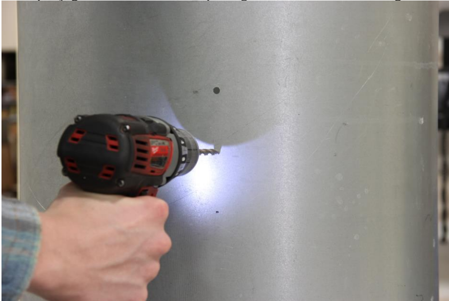
Figure 2: Percer chaque trou repéré et pointé avec le foret 1/4"
