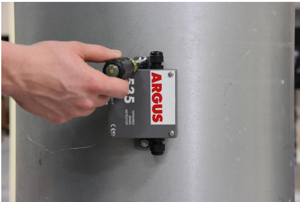
Figure 10: Placer le détecteur sur les vis de fixation
