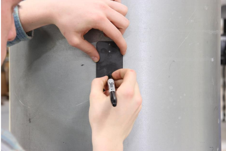
Figure 1: Repérer l'emplacement des trous en utilisant le gabarit de perçage
